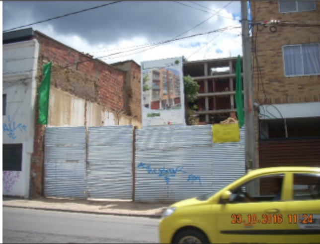
FOTOGRAFIA 1: Vista de tablero del elemento instalado, no cuenta con la información del Decreto Nacional 1469/2010
